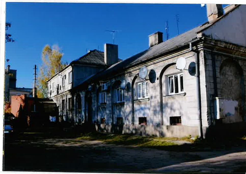
Fot. 7. Elewacja tylna, część zachodnia
