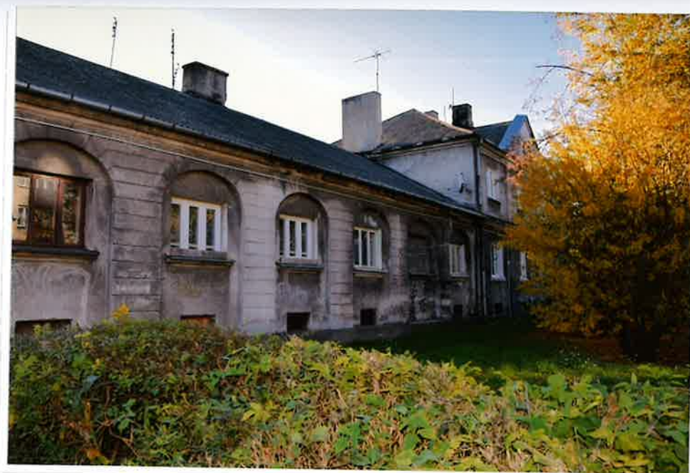
Fot. 5. Elewacja frontowa część zachodnia
