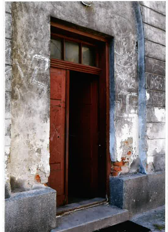
Fot. 10. Dzwi w przejeździe bramnym
